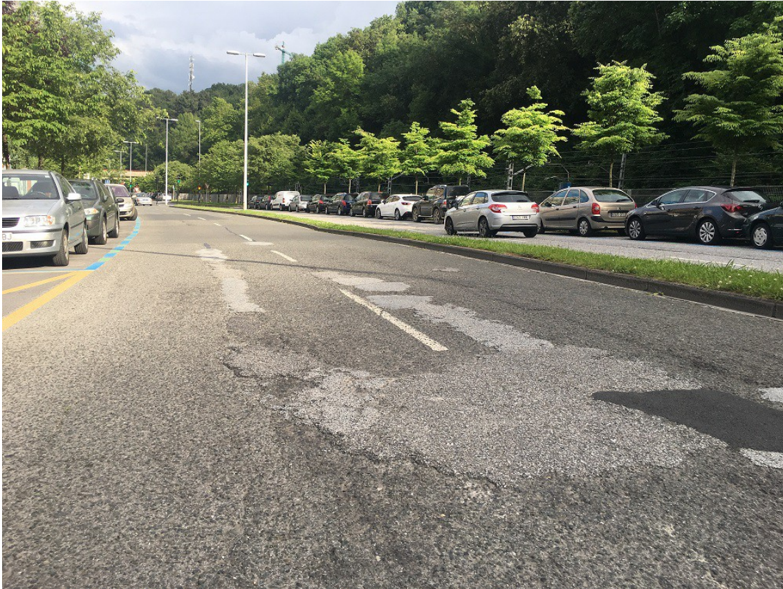
la calzada del Paseo de Errondo renovará su asfaltado
