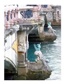
La restauración consistirá en la limpieza mecánica de sales, polvo, suciedad y excrementos de ave, aplicación de tratamientos biocidas, arreglo y sellado de elementos constructivos, reparación de grietas y fisuras. Se sanearán y repintarán los obeliscos en color ocre, los elementos decorativos de color dorado, se limpiarán y arreglarán los escudos de cerámica, así como los ojos de cristal que incluyen el nombre del puente y las farolas que están en la zona superior.
