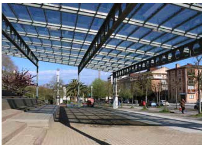
Cubierta en Harria.
